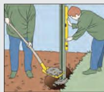
Betonelemente immer waagrecht montieren. Anfangspfosten einbetonieren (Kies, Sand-Zement-Gemisch; Betongüte C 16/20 – erdfeucht). Auf lotgenauem Ausrichten achten.
