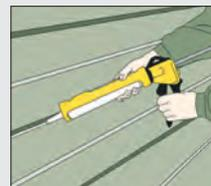
Für blickdichte und einheitlich geschlossene Optik: Zwischenräume der Plattenelemente mit Aussenacryl versiegeln. Erforderliche Aussentemperatur: ab 14 °C.
