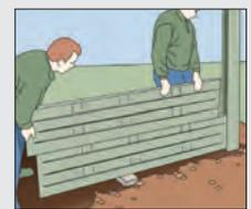
Betonplatten bis zur Oberkante der Randpfosten in Waage einsetzen. Einzelne Platten verkeilen.
