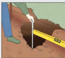
Punktfundamente für Pfosten erstellen. Erdloch für Anfangspfosten (40 cm x 60 cm x 100 cm) nach statischer Vorgabe ausheben, um frostfreie Gründung zu garantieren.
