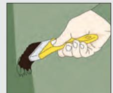
Zum dauerhaften Betonschutz: Zaun mit Beckers Betonzaun Farbe behandeln – idealerweise mit Lackiergerät. Farbe gut aufrühren, mit 10 % Wasser verdünnen. Zwei Arbeitsgänge nötig. Ergiebigkeit ca. 0,4 Liter/qm.
