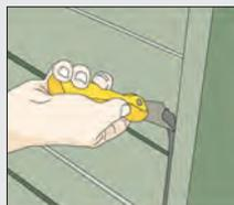
Pour une image uniforme, aligner les plaques à l'aide d'un levier. Réparer les retouches (petites cassures ou fissures) avec du mastic. Remplir les joints avec du mortier de jointoiement et lisser.
