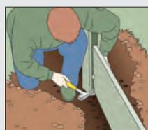
Presser le côté motif contre le poteau, caler le joint avec une pierre. Lors d'une construction double face: placer deux plaques dos à dos, caler entre les plaques.
