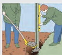
Toujours monter les éléments en béton horizontalement. Sceller les poteaux dans du béton au départ (gravier, mélange ciment-sable; qualité du béton C 16/20, terre humide). Veiller à un alignement précis.
