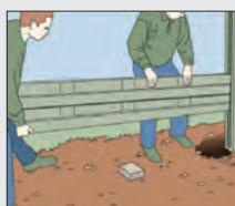
Poser la première plaque en béton à l'endroit souhaité dans la rainure. Soutenir l'extrémité de la plaque avec un pavé: mettre la dalle en équilibre et la poser fermement.
