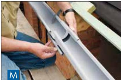
La pièce de jonction est montée sur le pli arrière et le bourrelet avant. Respectez les marques (système d'ergots et de rainures) !
