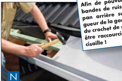
Les bandes de ruissellement offrent une protection supplémentaire contre les intempéries. Elles sont suspendues dans le chanfrein de la gouttière et fixées sur le linteau, à l'aide de clous de toiture, avec des espacements de 30 cm. Les bandes de ruissellement sont posées avec un enchevauchement de minimum 4 cm.
