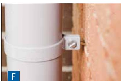
Le tuyau de descente est assuré à l'aide d'un « collier point fixe » au niveau de son extrémité supérieure. Pour ce faire, seule la vis à œillet est montée entre les pattes du collier. Ainsi, le tuyau de descente peut être solidement fixé, à cet endroit. Espacement des colliers : 2,00 à 2,50 m.
