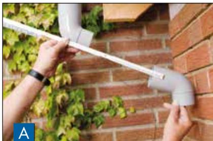
Enfilez un coude sur le manchon et mesurez l'écart jusqu'au contre-coude. Pour ce faire, tenez compte de la profondeur d'enfoncement de 4 cm et de l'écart par rapport au mur de la maison. Dans le cas d'avant-toits étroits, reliez 2 coudes directement à l'aide d'un raccord de coude.
