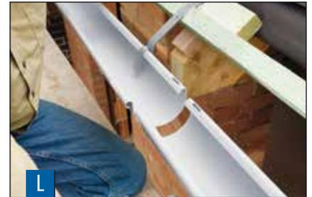
Les gouttières sont raccordées au moyen d'une pièce de jonction. L'écart requis entre les extrémités des segments est visible grâce aux marques situées sur la pièce de jonction.
