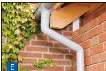
La pose des tuyaux s'effectue au moyen de colliers fixés grâce à des chevilles placées dans le mur de la maison. On distingue alors des « colliers point fixe » et des « colliers coulissants ».
