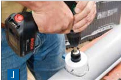
La découpe du trou destiné au tuyau d'écoulement peut être réalisée rapidement et proprement au moyen d'une scie-cloche ou d'une scie à denture fine.
