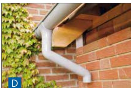
Les différentes pièces du système de tuyaux de descente sont simplement emboîtées les unes dans les autres. En raison de la profondeur d'emboîtement des pièces moulées, aucun joint n'est nécessaire.
