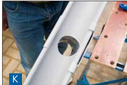
Lissez le côté scié et attachez le manchon d'écoulement au pli arrière et au bourrelet avant.
