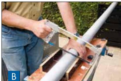
Les tuyaux de descente Marley peuvent être divisés facilement et rapidement à l'aide d'une scie à denture fine. Astuce : Afin d'obtenir une coupe droite, pensez à utiliser une boîte à onglets.
