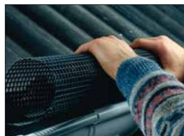
La grille Poly-Net Laubstop est installée dans la gouttière et tient par sa propre contrainte. Facile à travailler puisque Poly-Net Laubstop de Marley est livrée par bandes de 2,00 m.
