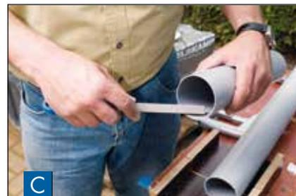
Lissez et nivelez les arêtes de l'extrémité du tuyau de descente. Particulièrement lors de l'installation d'un collecteur d'eau de pluie Marley, la contenance peut être ainsi considérablement accrue.
