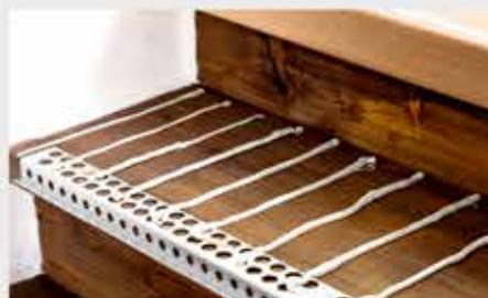
Appliquer la colle de montage parallèlement au sens de montée de l'escalier.
