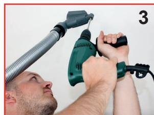
Staubsauger einschalten und den **bohrfixx** an die gewünschte Stelle (an Wand oder Decke) platzieren. Bohrer durch die Metallmanschette führen.
