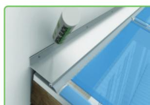
Anschließend dichten Sie die Wandfuge mit guttagliss Silikon ab.
