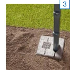
3 Stein im Erdreich verdichten, restliche Öffnungen mit Splitt, Sand, Kies, etc. verfüllen, erneut Lot überprüfen.
