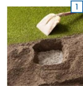
1 Loch ausheben und Untergrund für den Fundamentstein mit Splitt o.ä. vorbereiten.
