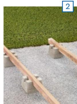
2 Zur Vermeidung von Graswuchs unter der Terrasse den Zwischenraum zwischen den Steinen mit Vlies auslegen und mit Splitt bedecken. Einsetzen der Unterkonstruktionshölzer in die Fundamentsteine.
