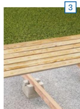
3 Verlegung der Terrassenbretter. Die Auswahl der Schrauben zur Verbindung der Konstruktionshölzer mit den Brettern ist abhängig von der Wahl der Holzart und bei Ihrem Händler zu erfragen.
