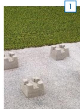
1 Verdichtung des Untergrundes zur Vorbereitung der Verlegung der Fundamentsteine mittels Sand oder Splitt.
