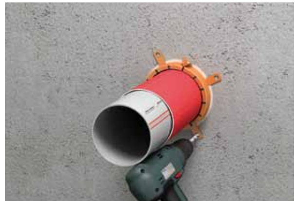
Befestigungspunkte ggf. anzeichnen und erstellen
