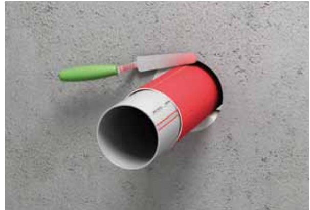
Rest- bzw. Ringspalt rauchgasdicht verschließen
