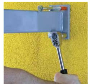
Nach Armierung und Auftragen des Oberputzes, einschließlich ausreichender Trocknungszeit, kann das Bauteil montiert werden.
