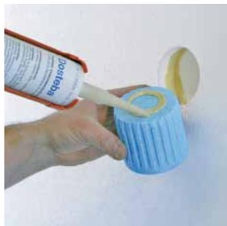
Tragen Sie anschließend den beiliegenden Montagekleber auf die Rückseite des Montagezylinders ZyRillo auf.
