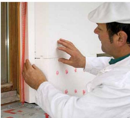
Sind die Fenster mit Laibung eingebaut, werden hier Laibungsplatten in einer Dicke von 2 – 4 cm eingebaut. Dabei wird die Fassadenplatte über die Laibung hinausgezogen und die Laibungsplatte zwischen Fensterrahmen und Fassadendämmplatte geklebt.
