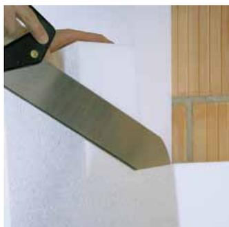
Schneiden Sie an der ausgesuchten Stelle eine Öffnung in den Maßen des Montagequaders Quadrolino in den Dämmstoff.
