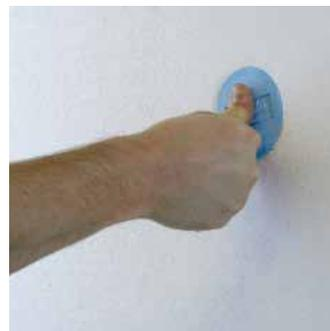
Den Montagezylinder ZyRillo umgehend oberflächenbündig in das vorbereitete Loch schieben.
