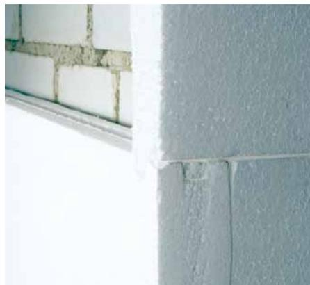
An den Gebäudeecken ist eine Verzahnung der Dämmplatten vorzunehmen (versetzte Stöße).
