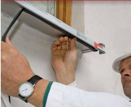
Anschlüsse an der Fensterbank sind mit Fugendichtband auszuführen. Hohlräume unter der Fensterbank mit Dämmstoff ausfüllen. Eine ausreichende Wasserablaufneigung muss eingehalten werden.
