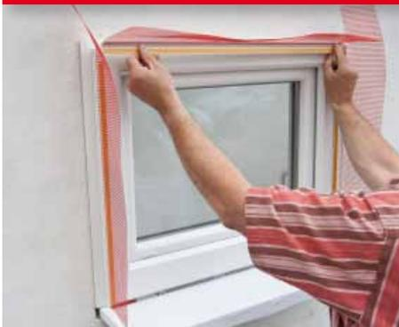
An Fenstern und Türen werden auf den seitlichen und den oberen Rahmen die Anputzleisten angebracht. Sie sind schlagregen- und winddicht und bilden die Abdichtung zwischen Dämmsystem und Fenster.
