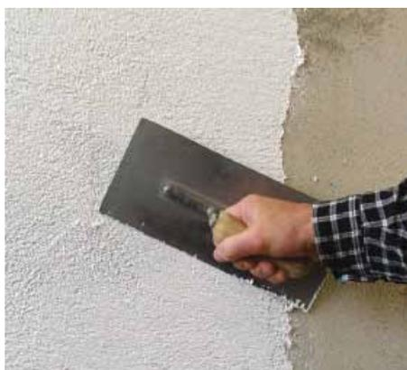
Nach Auftragen der Baumit Universalgrundierung und mindestens einem Tag Standzeit kann der Oberputz aufgetragen werden. Ziehen Sie den Oberputz mit einer rostfreien Stahltraufel mit leichtem Druck in Kornstärke auf. Verputzen Sie die Fassade von oben nach unten.
