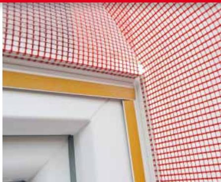
An den Ecken wird ein Teil des Kunststoffprofils abgeschnitten, das angeschweißte Gewebe jedoch stehen gelassen. Mit diesem Gewebe wird die Innenecke überlappt, um eine größtmögliche Sicherheit vor Rissen zu gewährleisten.
