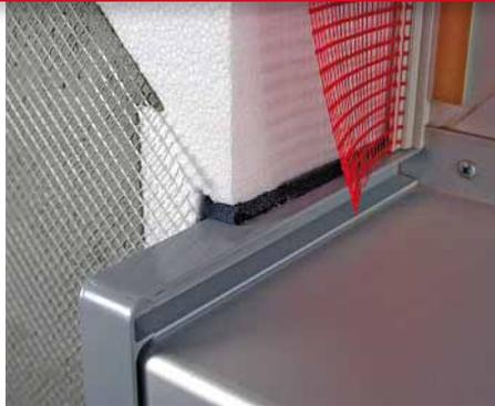
Das Fugendichtband ist auch seitlich sowie auf der oberen Abkantung des Fensterbankeckstückes zu montieren. So entsteht eine umlaufende Abdichtung.
