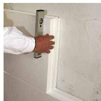
Die verklebte Platte mit Hilfe einer Wasserwaage ins Lot bringen. Plattenfugen bis 5 mm können mit easytop Klebeschäum ausgeschäumt werden.
