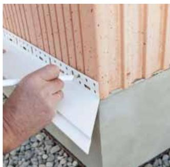
Nach Festlegen der Einbauhöhe wird das erste Bohrloch markiert und mit passendem Bohrer gebohrt. Anschließend legen Sie eine Wasserwaage auf das Profil, richten es aus und markieren die weiteren Bohrlocher alle 30 – 35 cm.
