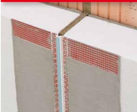
Dehnfugen im Mauerwerk müssen in das Dämmsystem übernommen werden. Dafür werden die Dämmplatten mit einem Spalt von ca. 10 – 15 mm an die Dehnfuge herangedämmt. Der Spalt muss mit einem Mineralwollstreifen gefüllt werden, um Wärmebrücken zu vermeiden.
