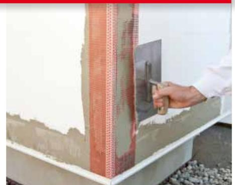
An den Außenecken an Fenstern und Türen sowie an Hausecken wird ein Eckprofilwinkel lot- und fluchtgerecht mit Klebspachtel angebracht.
