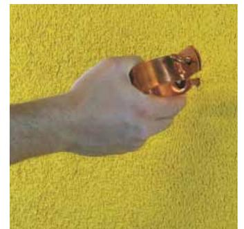
Nach Armierung und dem Auftragen des Oberputzes, einschließlich ausreichender Trocknungszeit kann das Bauteil eingeschraubt werden.
