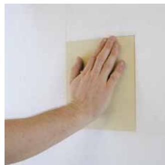
Anschließend den Montagequader einschieben. Es darf kein Kleber auf die Würfelflanken kommen, um Wärmebrücken zu vermeiden.
