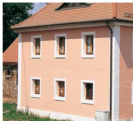
Bei farbigen, mineralischen Putzbeschichtungen ist immer ein abschließender Egalisationsanstrich im Putzfarbton auszuführen, da der Putz abhängig von der Witterung ungleichmäßig abtrocknen kann und Farbabweichungen entstehen können.
