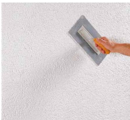
Je nach gewählter Struktur wird der Oberputz mit einem Kunststoff-Reibebrett fertig strukturiert. Die Arbeiten am Oberputz müssen zügig durchgeführt werden, daher sind zumeist mehrere Arbeitskräfte erforderlich.
