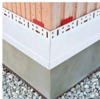
An Außen- und Innenecken werden die Profile mit passendem Werkzeug (Eisensäge, Winkelschleifer o.ä.) auf Gehrung geschnitten.
