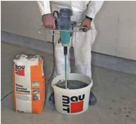
Klebspachtel Allround mit Wasser in einem geeigneten Gefäß mit einem elektrischen Rührstab anmischen, bis ein homogenes und knollenfreies Material entsteht.
