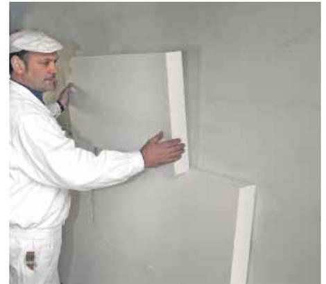
Die mit Kleber versehene Platte an die Wand kleben und lotgerecht ausrichten. Zum Andrücken der Dämmplatten sollten Sie diese nicht mit den Händen anschlagen, da dies die Oberfläche beschädigen kann. Nutzen Sie hierfür ein großes Reibebrett.
