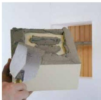
Zur Montage wird auf die Rückseite des Montagequaders Quadrolino der Klebspachtel Allround aufgetragen.
