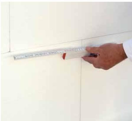
Dämmplatten werden grundsätzlich im Versatz geklebt. Dieser sollte ein Viertel der Dämmplattenlänge betragen, in der Regel entspricht dies mind. 25 cm.
