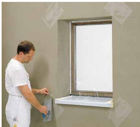
Diagonalarmierung – Einlegen eines Gewebestücks 30 x 40 cm oder Armierungspfeil diagonal an den Ecken von Fenster und Türen. Innenecken an Fensterlaibungen sind ebenso herzustellen.
