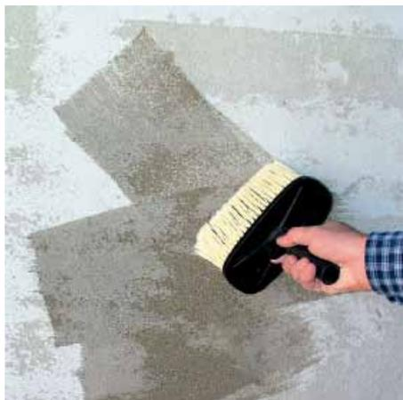
Tiefengrund zur Verbesserung der Untergrundhaftung und zum Egalisieren der Saugfähigkeit.
