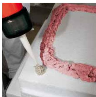
An den oberen Ecken zwei Vorfixierungspunkte easytop Fixierkleber (je ca. 10 g) aufbringen. Unten wird die Platte durch die Nut- und Federausbildung gehalten. Platte leicht an die Wand drücken. Nicht fest anklopfen (Kleberstruktur wird zerstört).
