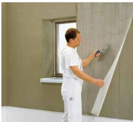
Ziehen Sie den angerührten Klebspachtel mit einer Zahntraufel (10 mm Zahnung) auf die Dämmplatte auf. In der Regel beginnt man oben und arbeitet sich an der Fassade nach unten.
