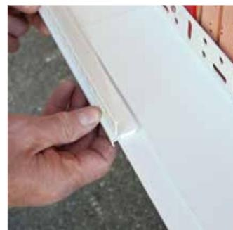
Ziehen Sie den Schutzstreifen vom Abschlussprofil und kleben Sie es auf die definierte Vorderkante des Sockelprofils. Dabei dient es gleichzeitig als Sockelschienenverbinder.
