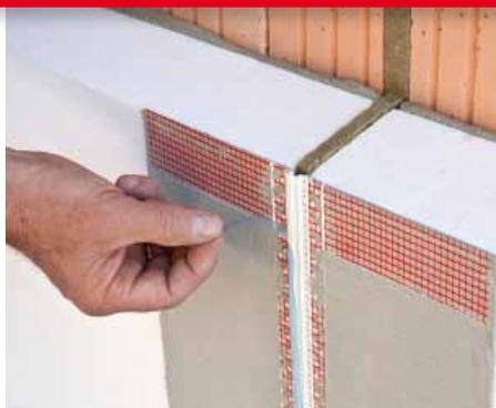
Anschließend wird das Dehnfugenprofil mit Klebspachtel angebracht. Das Dehnfugenprofil darf nicht mit Klebspachtel und Oberputz überspachtelt werden. Nach Abschluss der Spachtelarbeiten wird der Schutzstreifen vom Profil entfernt.
