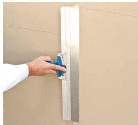
Zum Abschluss wird die frische Armierungsschicht mit einem Flächenglätter sauber abgezogen. Es dürfen keine Kanten oder Grate mehr auf der Armierungsschicht sein.
