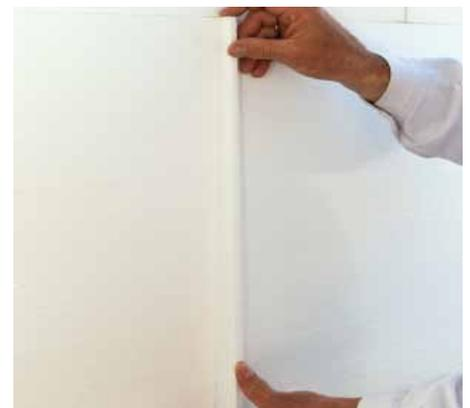
Fugen größer 5 mm sind mit einem Dämmstoffkeil zu verschließen. Dafür einfach ein entsprechendes Stück abschneiden und in die Fuge drücken. Auf keinen Fall darf die Fuge mit Klebspachtel verschlossen werden, da dies zu Wärmebrücken führt.
