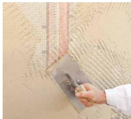
Anschließend sofort das Gewebe einlegen und mit der Zahntraufel leicht andrücken. Mit der glatten Seite der Traufel wird das Gewebe jetzt in den Armierungspachtel eingebettet, es sollte im oberen Drittel der ca. 3 – 5 mm starken Armierung liegen.
