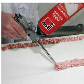
Umlaufend und mittig einen ca. 6 cm starken Strang aufbringen. Die Dämmplatte sollte zu ca. 40 % mit Klebeschäum bedeckt sein.
