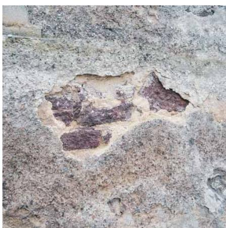
Lose Putzstellen und Hohlstellen abklopfen, anschließend mit Haftputz verschließen.
