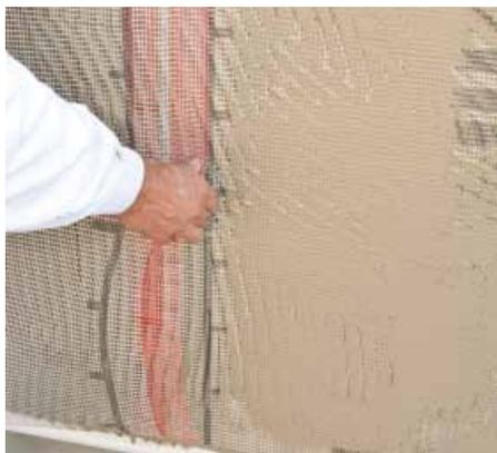
Das Armierungsgewebe ist im Stoßbereich (Armierungsgewebe, Eckprofilwinkel, Anputzleiste) mindestens 10 cm überlappt zu verlegen. Der schwarze Streifen am Rand des Baumit Armierungsgewebes dient dabei als Orientierung.
