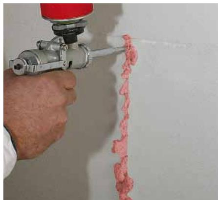
Eventuelle Fugen im Stoß- oder Lagerbereich bis 5 mm werden mit easytop-Klebschaum verschlossen und Restmaterial oberflächenbündig abgeschnitten.
