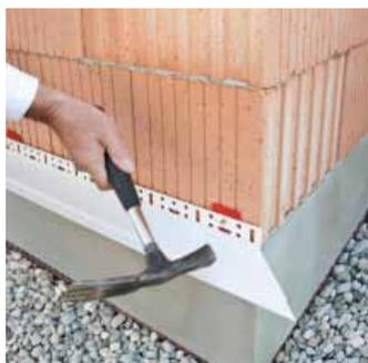
Mit Ausgleichstücken werden mögliche Unebenheiten im Untergrund ausgeglichen. Die Bauteile mit Ausgleichstücken werden direkt auf den Bauteile mit Nageldübel gedrückt und können so während der Montage nicht herunterfallen.
