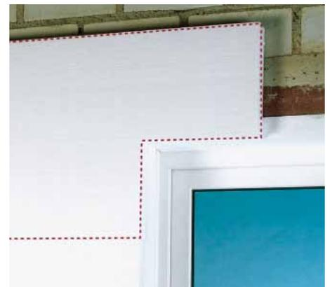
An Fenster- und Türöffnungen die Dämmplattenfuge nicht über die Fensterecke fortführen, sondern ausklingen (Pistolenschnitt). Kreuzfugen sind zu vermeiden.
