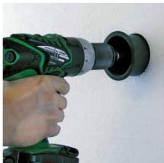
Mit dem beiliegenden Fräs Werkzeug fräsen Sie an der ausgewählten Stelle ein Loch in die Dämmplatte.
