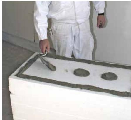
Der Auftrag des Mörtels erfolgt von Hand mit einer rostfreien Edelstahlkelle. Mit der aufgezeigten Randwulst-Punkt-Methode ist eine 40 %ige Teilverklebung der Platten gewährleistet.
