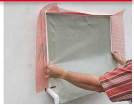
An der Schutzlippe wird die zuvor zugeschnittene Schutzfolie für das Fenster/die Tür angeklebt. Diese Lippe ist vorperforiert und kann nach Abschluss der Arbeiten leicht entfernt werden.
