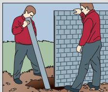
Zweiten Pfosten passgenau an Elemente ansetzen, lotgenau ausrichten und einbetonieren. Beton für zusätzliche Lastverteilung bis unter die Platten anfüllen.
