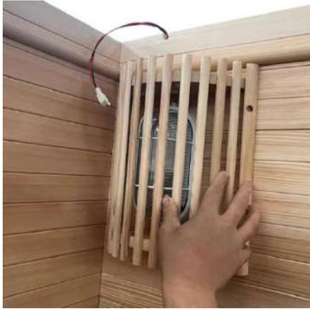
(15) Montieren Sie die Holzabdeckung für das Saunalicht (3x25mm Schrauben 8 Stück)
