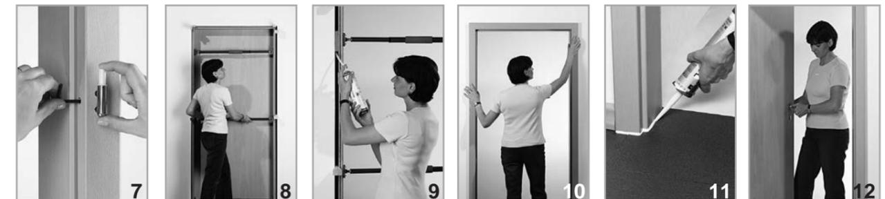
Relâcher éventuellement les vis 6 pans creux avant le placement. Introduisez les fiches et serrer les vis au couple 6-6,5 Nm avec une clé allen en T de 4mm, sans quoi la fiche peut sortir de son logement sous l'action du poids de la porte.
