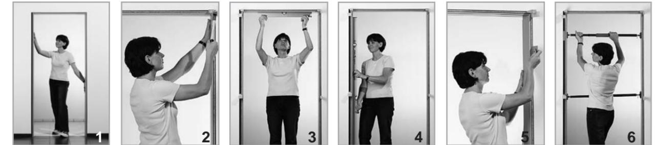
Placer l'ébrasement assemblé dans la cloison. En cas de sols durs, nous recommandons, en principe, de laisser un espace de 3mm afin d'éviter les dommages dus à une humidité montante (par ex. eau de nettoyage). Le matériau de calage devra rentrer légèrement en face de l'arête visible pour que le joint silicone soit parfait.
