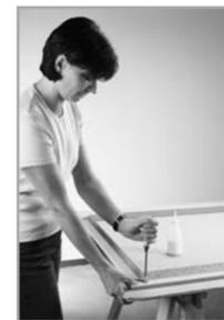
D'après le même principe, collez et assemblez les habillages du contre chambranle (**attention au temps de séchage de la colle**). Placer ensuite l'ébrasement assemblé dans l'ouverture du mur (voir page 3).
