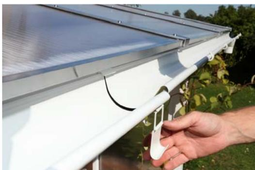
Joignez les gouttières semi-circulaires au moyen de raccords de gouttière (C161-01/02), comme suit: placez 3 cordons en silicone (C193) sur l'élément en caoutchouc
