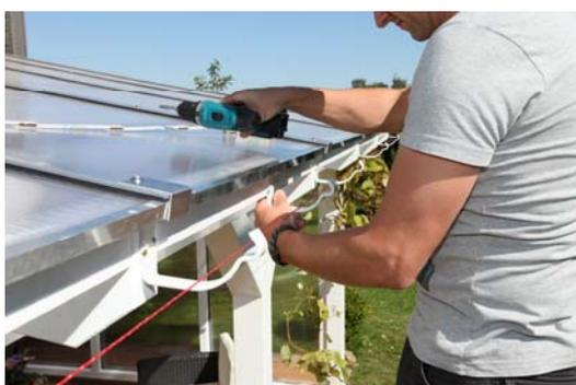
Tendez un cordon entre le premier et le dernier support de gouttière pour déterminer la hauteur des autres supports. Fixez ensuite un support de gouttière le long du cordon sur chaque tête de chevron restant et répartissez les supports restants entre les supports montés.
