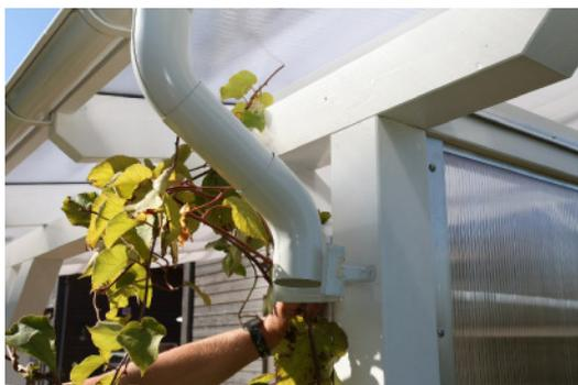
Coupez le raccord de tuyau (C167-01/02) à la longueur voulue. Faites attention à enfoncer suffisamment le tuyau et le tuyau coudé (C166-01/02) l'un dans l'autre.
