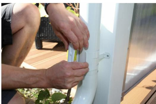
Coupez le tuyau d'écoulement (C165-200-01/02) à la longueur voulue et enfichez-la dans l'écoulement inférieur (C168-01/02). Faites attention que la jointure pointe vers l'avant. Montez le collier d'attache inférieur sur le raccord entre le tuyau d'écoulement et l'écoulement au moyen de deux vis. Serrez le collier d'attache et glissez la clavette de serrage dessus (avec une pièce en bois p. ex.).
