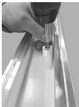
Stopper mit Schraube befestigen
