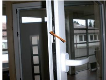
3. Flügel auf der Bandseite anheben und senken mit 4 mm Inbusschlüssel
