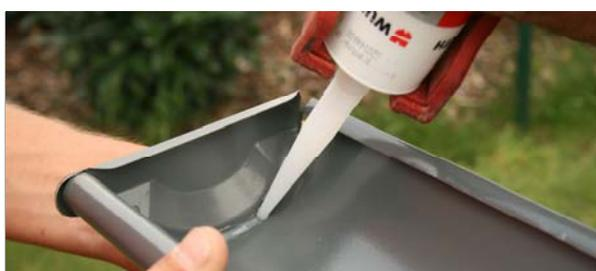
Nun bringen Sie an beiden Enden die Rinnenendstücke (C162-01) an (z.B. mit einem Gummihammer) und dichten diese mit Silikon ab.
