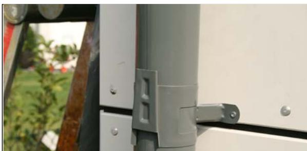
Coupez le tuyau de descente (C165-200-01) à la bonne longueur et raccordez-le à la sortie d'écoulement inférieure (C168-01), veillez à ce que la soudure soit vers l'avant. Montez le collier inférieur par-dessus la pièce de jonction entre le tuyau de descente et la sortie d'écoulement avec 2 vis, pincez le collier et enfitez la cale de fixation par-dessus (p. ex. en tapotant avec un morceau de bois).
