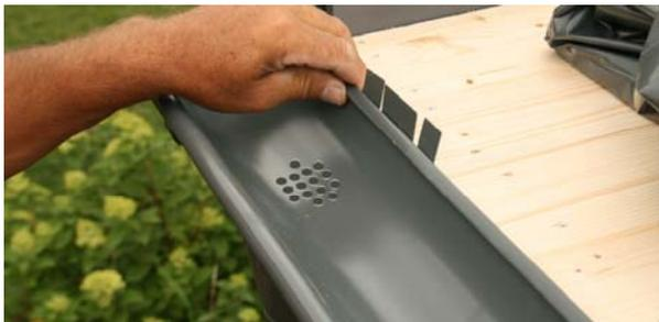
Positionnez maintenant le connecteur d'écoulement (C164-01) sur le côté correspondant du bâtiment. (Attention à la pente !)
