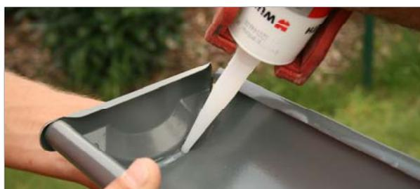
Fixez maintenant les deux embouts (C162-01) aux extrémités de la gouttière (p.ex. avec un marteau en caoutchouc) et réalisez l'étanchéité avec de la silicone.
