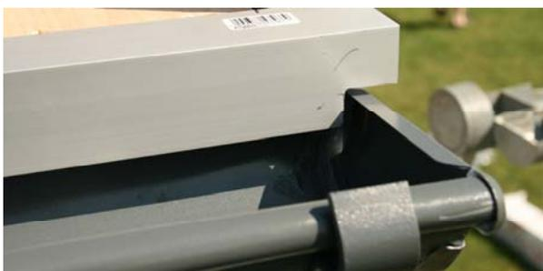
Placez ensuite la gouttière arrondie avec le connecteur d'écoulement (C164-01) dans les crochets. Il faut éventuellement adapter un peu la gouttière après la pose dans les crochets en la pliant légèrement pour modifier un peu le rayon.
