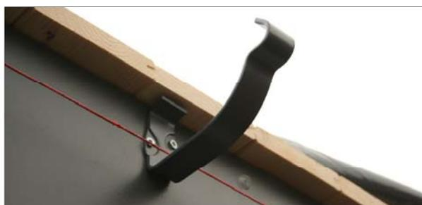
Tendez une ficelle entre le premier et le dernier crochet pour déterminer la hauteur de pose des autres crochets. Répartissez ensuite les autres crochets à intervalles réguliers entre les crochets des extrémités.
