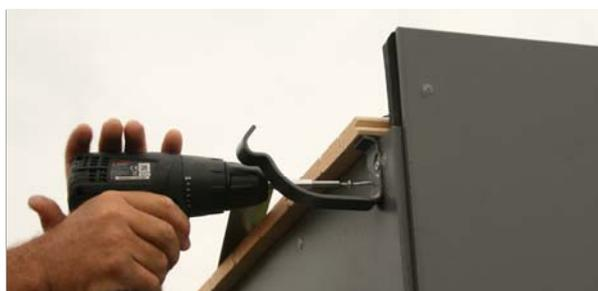
À l'arrière du bâtiment, fixez les crochets (C163-01) avec 2 vis (C103-0040) (en commençant à env. 3 cm de chaque bord).
