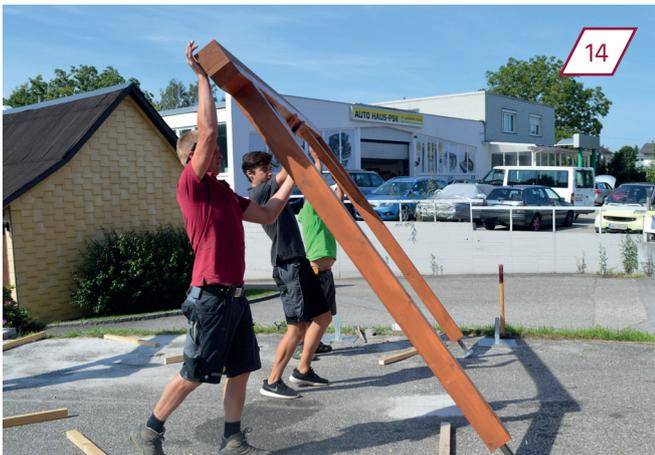
Mettre en place le mur avant. Placer le pied de support sur les fondation de béton.
