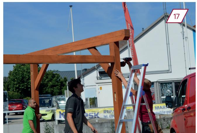
Visser les poteaux avec les montants. Éventuellement, ne les visser pas complètement, pour faciliter la fixation préalable du toit.
