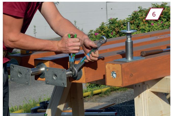
Avec l'aide de la clé et de la clé à pipe, serrer les pieds de support dans la direction opposée.
