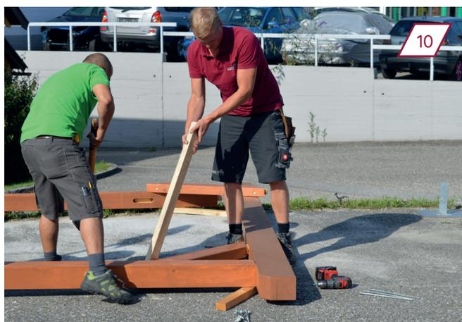
Installez les bandeaux (voir le plan du mur pour choisir le bon bandeau) avec des lattes et une masse entre le montant et le poteau supérieur. Répétez la même chose du côté opposé.
