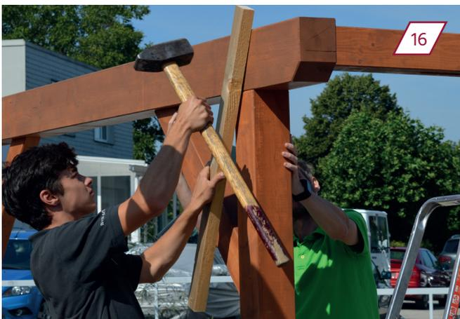
Mettre en place avec le marteau de forgeron et les lattes.
