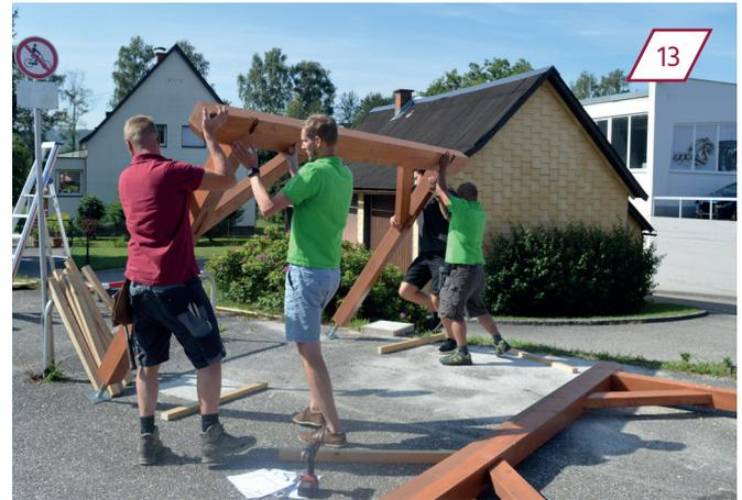
Mettre en place le mur arrière. Placer le pied de support sur les fondations de béton.
