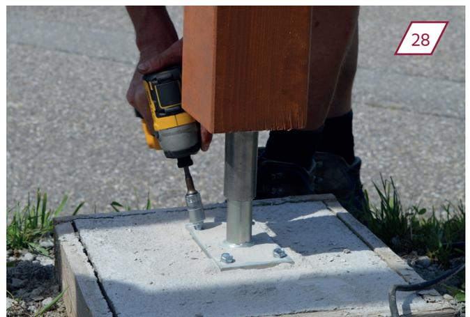
Visser le béton avec une clef de choc ou une clef plate. Serrer bien.
