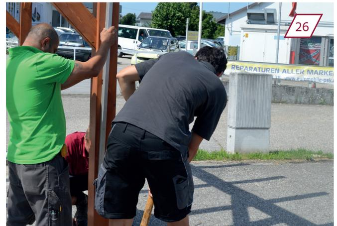
Tenir droit et aligner denouveau avec le niveau à bulle et réajuster avec latte et marteau au besoin.
