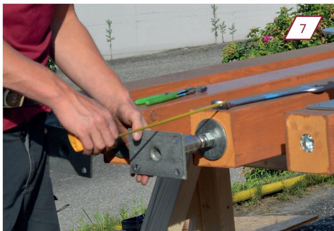
Définir la bonne longueur et l'aligner à la poutre. En règle générale, 20 cm sont déduits de la hauteur d'entrée pour les pieds d'appui. Exemple: pour une hauteur de passage de 250cm : 230cm de hauteur de colonne + 20cm de pieds d'appui.
