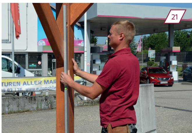
Si nécessaire, ajuster avec le marteau et la latte.
