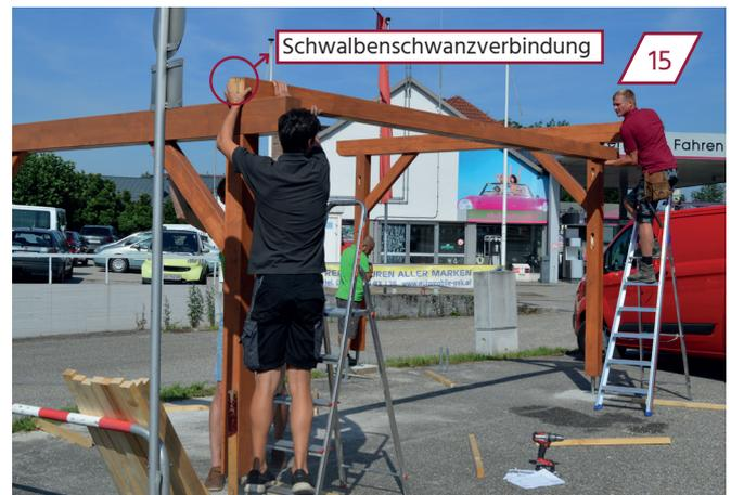
Placez le poteau latéral entre le mur arrière et le mur avant. Faites glisser l'articulation en (queue d'aronde ?) sur le côté inférieur.
