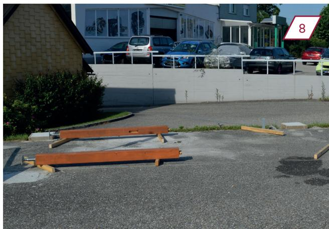
Placez deux colonnes du mur du fond parallèles entre elles sur des lattes à bonne distance l'une de l'autre. Au mieux, les pieds d'appui des colonnes devraient déjà être proches des fondations.
