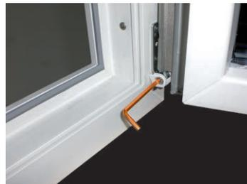
**Die Verstellung der Bandteile dient nicht der Korrektur von Einbaufehlern, sondern zur Korrektur späterer Veränderungen.**
