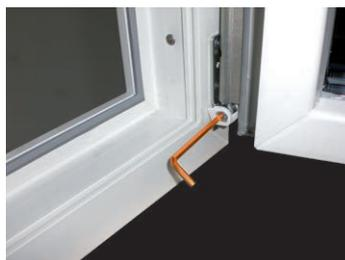
**Le réglage ne permet pas la correction des erreurs de pose mais à rectifier les modifications ultérieures.**
