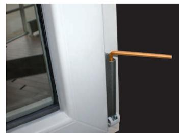
4. Réglage du vantail latéralement à l'aide de la clé 6 pans.
