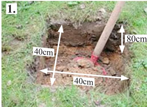
Eine Grube für jeden Pfosten ausheben.
