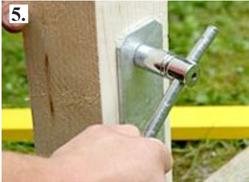
5. Die Schraube mit Mutter und 2 Unterlegscheiben fixieren.
