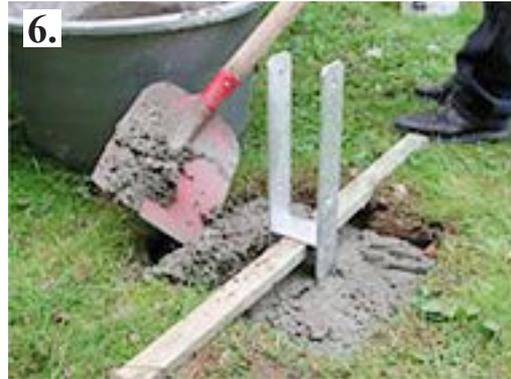
6. Füllen Sie Beton in das ausgegrabene Loch. Der H-Pfostenanker bleibt weiterhin mit der Leiste fixiert. Danach den Beton glattstreichen.
