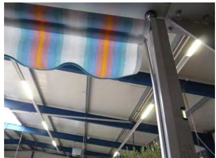
Klemmpfosten ausrichten und leicht verspannen. Zeichnen Sie nun durch die Löcher der Teller einen Befestigungspunkt an. Jetzt müssen Sie die Klemm- Markise nochmals abmontieren, damit Sie das Befestigungsloch bohren können.
