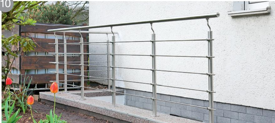
Une fois que vous avez raccordé les barreaux et les main-courantes redressez la balustrade et réajustez éventuellement les espacements entre poteaux pour harmoniser l'ensemble
