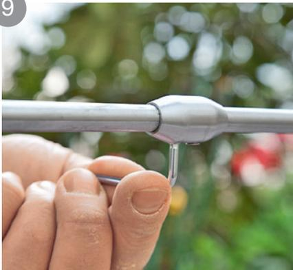
Pour relier les barreaux, utilisez ces raccords. Pour la main courante, il y a un raccord de liaison
