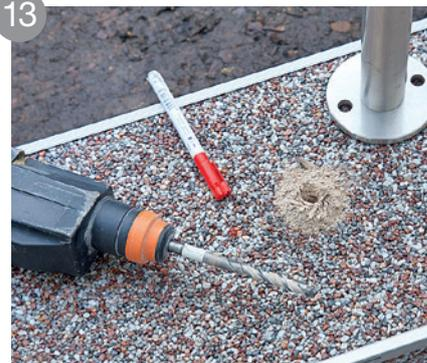
Marquez la position des vis à travers les plaques de fixation, décalez la balustrade, percez les trous et nettoyez-les
