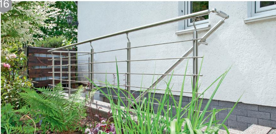
À la fin de votre installation, vérifiez le serrage des vis et faites un nettoyage complet (A l'eau savonneuse par exemple). Ainsi votre balustrade gardera au fil du temps toute sa splendeur.
