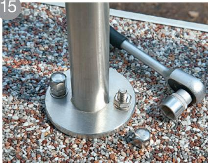
... mettez les vis ou tiges filetées et fixez-les avec des boulons appropriés. Assurez-vous de l'aplomb des poteaux et caliez-les si nécessaire.
