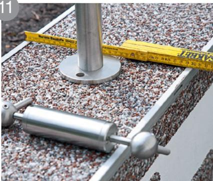
Lors d'une installation sur un rampant ou à un angle, vous devez insérer l'articulation dans l'adaptateur main-courante (voir 5)
