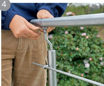
4 Redressez la balustrade et installez la main-courante (diam 40) sur le poteau
