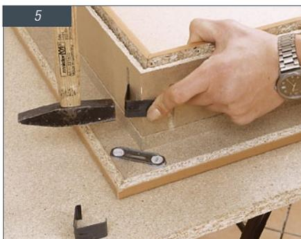
Schlagen Sie die Stahlklammern in die Nuten. Die Gehrungsschutzecken der Bekleidungen stecken Sie oben in den Zwischenraum, so dass die Wangen ...
