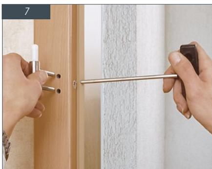
Richten Sie die Zarge nun auf und stecken Sie die Scharniere in die Bohrungen oben und unten. Von der Innenseite lassen sie sich feststellen.
