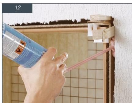
... verstellen gegebenenfalls die Spreizen. Passt alles, schäumen Sie mit 2-Komponentenschaum die Hohlräume zwischen Zarge und Wand aus.
