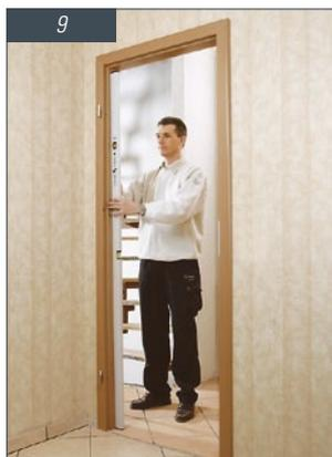
Die Zarge muss nun ausgerichtet werden. Verwenden Sie eine möglichst lange Wasserwaage/Richtlatte und kontrollieren Sie Innen- und Außenseite.
