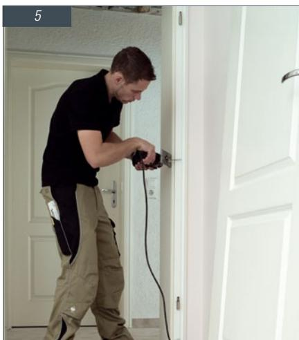
Das Futterbrett der alten Zarge wird im unteren Drittel mit einem sauberen Schnitt durchgesägt.
