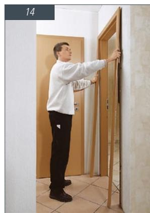
Entfernen Sie die Keile und Spreizen. Jetzt kann die Zierbekleidung von außen aufgesteckt werden.
