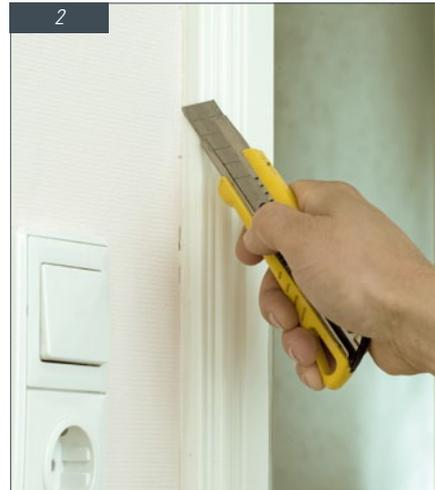
Um die Tapete beim Entfernen der Zarge nicht zu beschädigen, schneidet man mit einem Cuttermesser vorsichtig an der Zarge entlang.
