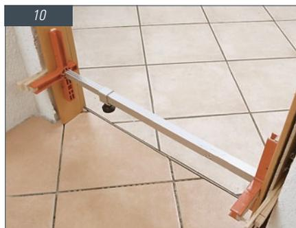
Haben Sie die Zarge ausgerichtet und mit ausreichend Keilen fixiert, setzen Sie die Spreizen ein. Achten Sie darauf, dass diese fest sitzen.
