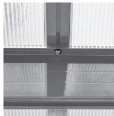
Sparrenverschraubung Edelstahl Schrauben/Muttern
