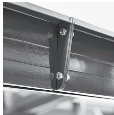
Pfettenverschraubung Edelstahl Schrauben/Muttern
