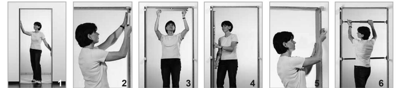
Placer l'ébraselement assemblé dans la cloison. En cas de sols durs, nous recommandons, en principe, de laisser un espace de 3mm afin d'éviter les dommages dus à une humidité montante (par ex. eau de nettoyage). Le matériau de calage devra rentrer légèrement en face de l'arête visible pour que le joint silicone soit parfait.
