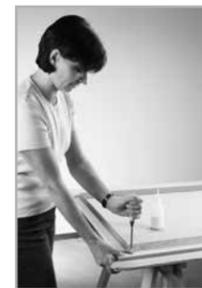
D'après le même principe, collez et assemblez les habillages du contre chambranle (**attention au temps de séchage de la colle**). Placer ensuite l'ébraselement assemblé dans l'ouverture du mur (voir page 3).
