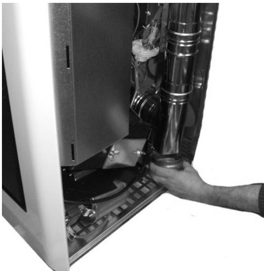
**Fig. 102 - Reinigung des Rauchgaskanals**
