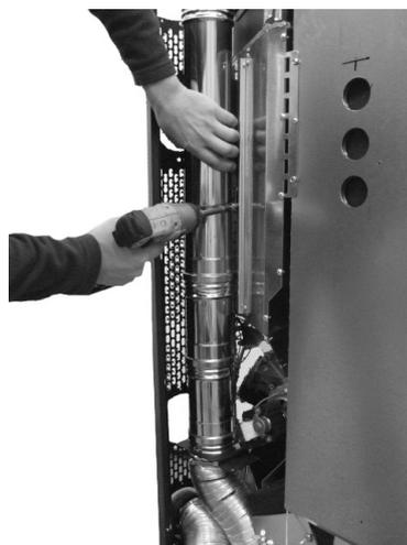
**Fig. 64 - Befestigung der Rohre**
