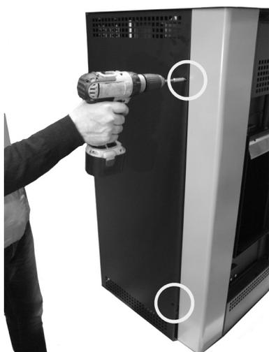
**Fig. 93 - Lösen seitliche Schrauben**
