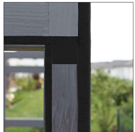
La bande d'étanchéité doit être collée bord à bord pour éviter les infiltrations d'eau !
