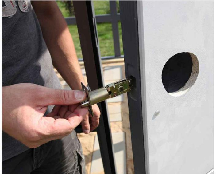
Posez maintenant la serrure de la porte. Glissez d'abord le pêne à l'endroit prévu à cet effet dans la porte et fixez-le à l'aide des deux vis jointes à la serrure. Attention à l'orientation du pêne !!
