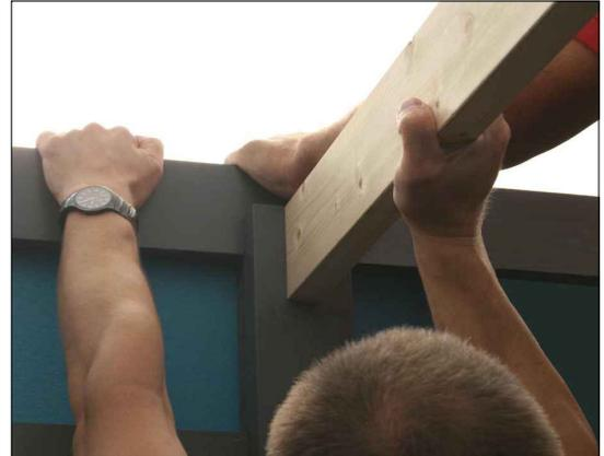
Afin de déterminer avec précision la hauteur de pose de(s) panne(s) et des supports de panne(s), positionnez une volige dans le sens de la hauteur, depuis le support de voliges à l'avant jusqu'à la panne sablière arrière. Marquez ensuite le bord supérieur de la panne afin de déterminer l'emplacement exact des supports de pannes.
