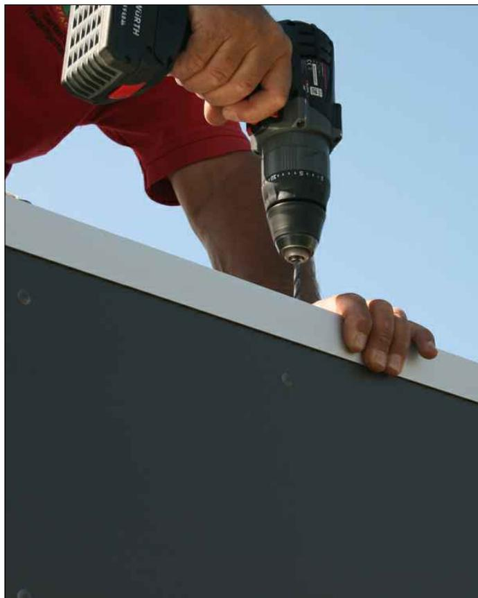
Après pré-perçage, vissez les rails en aluminium (A100-220) avec 6 vis 104-0030 sur la panne sablière au bord du toit. Laissez déborder les rails en alu de 2 cm sur la longueur.
