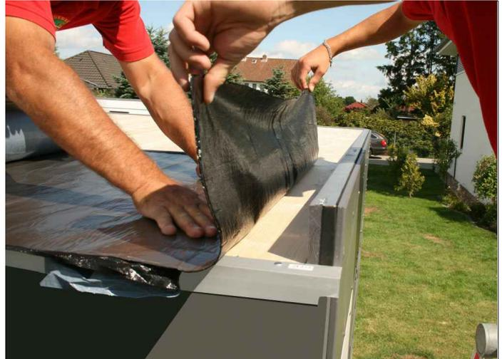
Posez maintenant le revêtement de toiture autocollant. Le revêtement doit être posé transversalement par rapport à la pente du toit. Déroulez environ 100 cm de revêtement et laissez pour l'instant le film de protection sur le revêtement afin de pouvoir ajuster exactement le revêtement. Ce n'est qu'après avoir ajusté exactement le revêtement qu'il faut retirer le film de protection sur 10 cm et fixer le revêtement avec précision.
