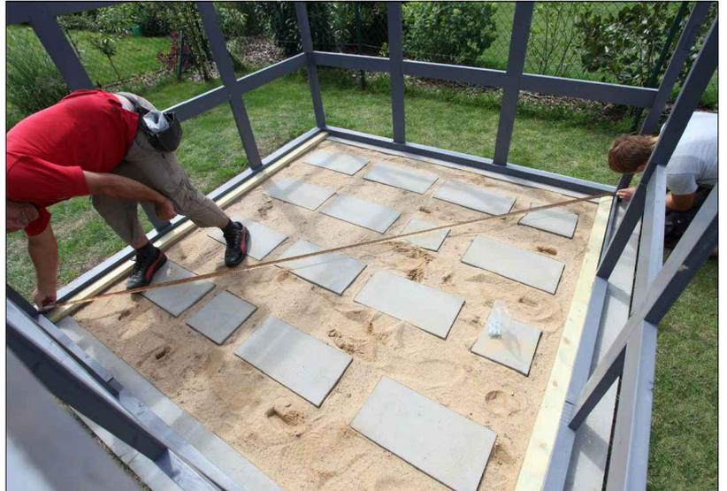
Vérifiez aussi les diagonales à l'aide d'un mètre ruban. Mesurer les diagonales à partir des coins opposés des madriers de seuil, les deux mesures doivent être égales.
