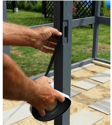
Collez sur le support de construction la bande d'étanchéité EPDM A109 (largeur de 9mm) et A111 (largeur de 30 mm). Pour les endroits où les plaques de façades se rejoignent, utilisez la bande A111, pour le haut et le bas du support de construction, posez la bande A109. La bande doit être collée bord à bord pour éviter les infiltrations d'eau. Collez la bande d'étanchéité à parts égales sur les angles des coins. Restez à 0,5 cm du bord en haut !
