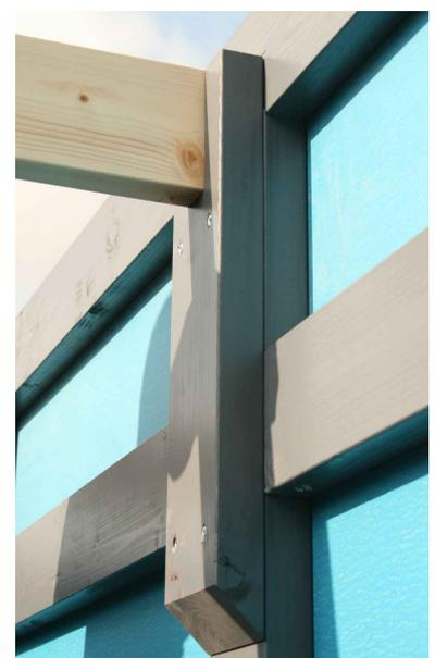
Posez le(s) panne(s) dans les découpes des supports et vissez le(s) panne(s) après pré-perçage de l'intérieur à travers les supports de panne avec chaque fois une vis C105-0080.
