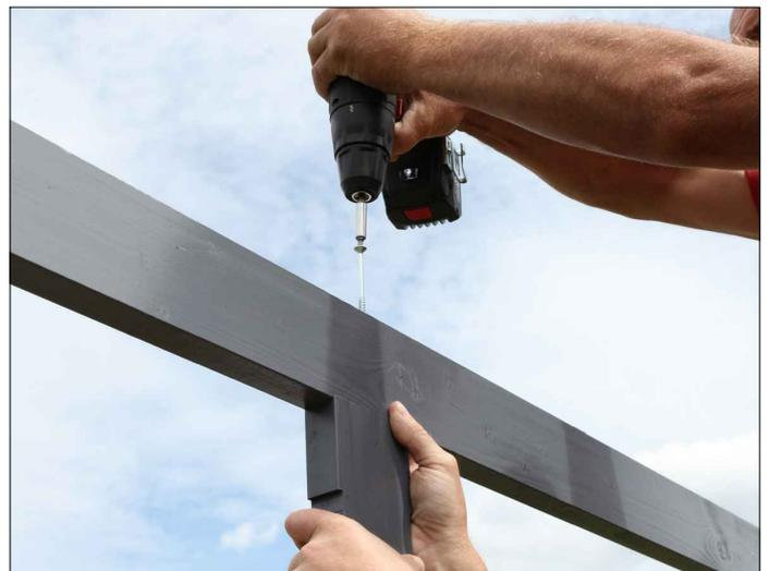
Insérez ensuite les poteaux intermédiaires et les poteaux d'angle dans les découpes respectives de la panne sablière, pré-percez et fixez les poteaux par le dessus des pannes en utilisant chaque fois 2 vis C105-0150.
