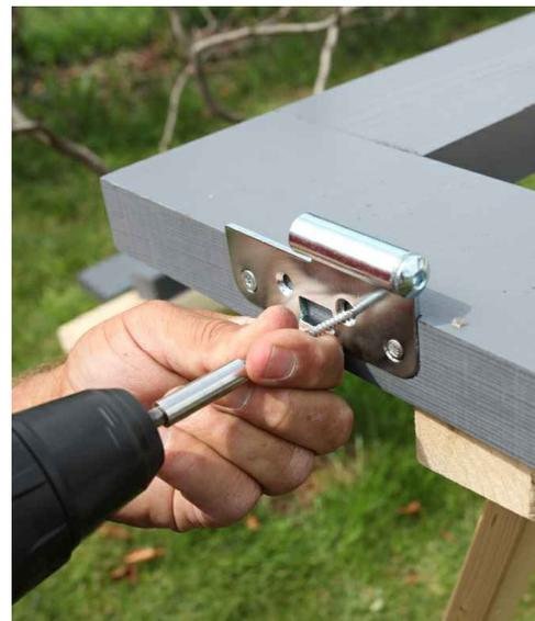
Positionnez la porte laissez du bon côté et fixez maintenant les trois paumelles de la porte (3x droite, 3x gauche) dans les découpes prévues à cet effet avec 4 des vis ci-jointes après pré-perçage.
