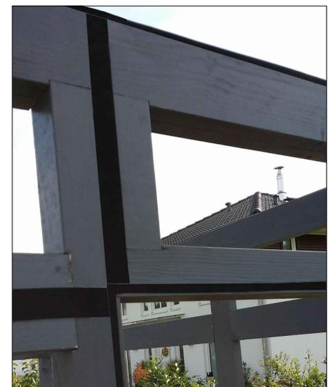
Commencez par coller la bande d'étanchéité (A109) en bas à 2cm du bord. De manière générale, collez toujours les joints bord à bord afin d'éviter les infiltrations d'humidité !
