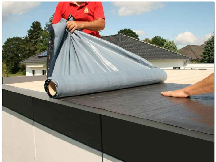
Laissez dépasser du bord assez de revêtement pour garantir une bonne finition de bordure. Avec avoir entièrement collé la première bande, posez la deuxième bande en recouvrant la première sur 20 cm. Vous garantirez un bon collage en passant un rouleau sur la zone de recouvrement.
