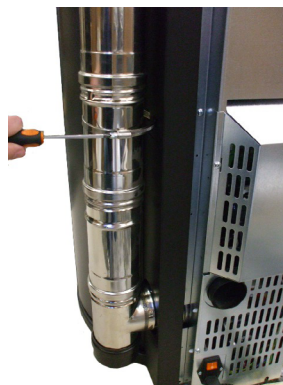
Fig. 86 - Collecteur des fumées (Sfera³ Plus, Sfera³, Globe, Elise³ Plus)
