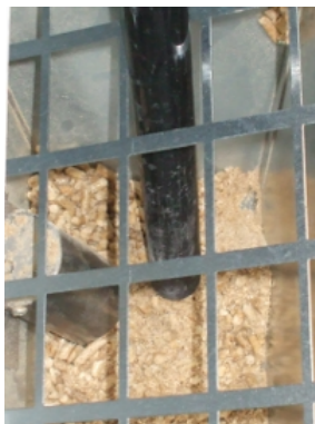
Fig. 63 - Nettoyage réservoir et vis sans fin
