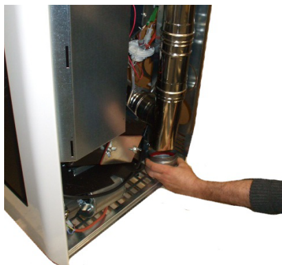
Fig. 85 - Nettoyage du collecteur des fumées
