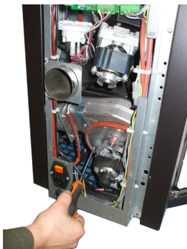
Fig. 87 - Nettoyage de l'aspirateur des fumées: phase 1
