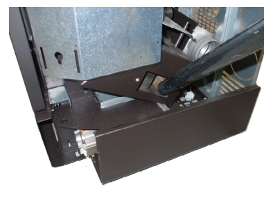
Fig. 84 - Nettoyage de la chambre des fumées
