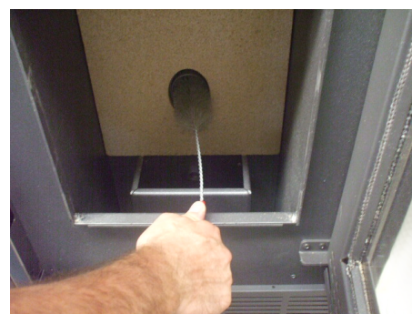
Fig. 62 - Nettoyage avec nettoie-pipes
