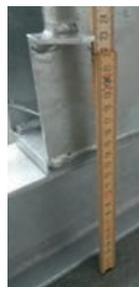
Profondeur d'encastrerement de la poutre en acier (env. 22,5 cm)
