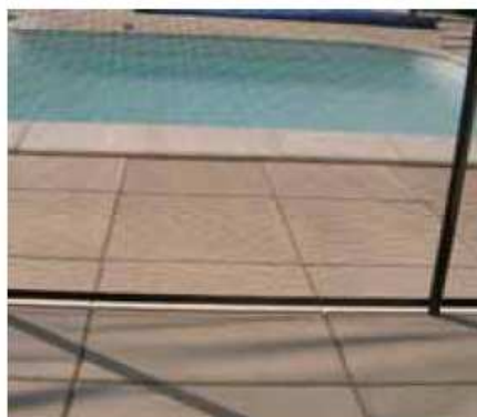
Obrázek 7. Ujistěte se o dobrém napnutí sítě a o dodržení svtlé výšky
