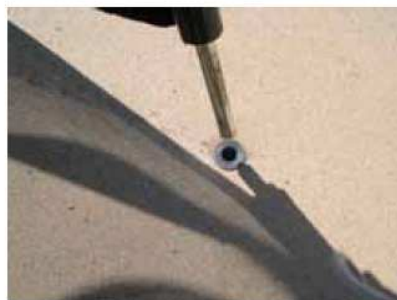
Figure 5. Fixation du fourreau d'ancrage au sol
