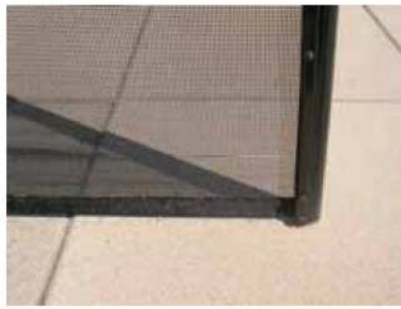
Figure 6. La tige inox doit être complètement enfoncée dans le fourreau d'ancrage (loquet de sécurité côté bassin )
