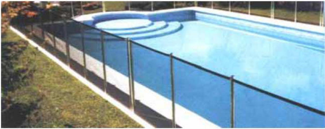
Figure 9. Le filet doit être bien tendu entre chaque poteau
