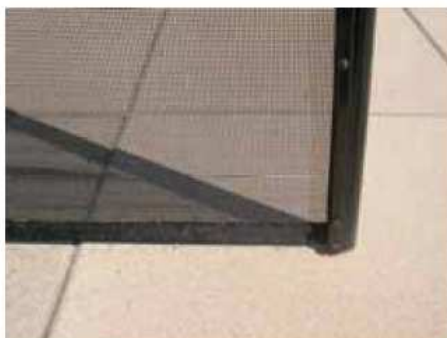
Figura 6. Tija de inox trebuie să fie complet înfiptă în teacă de ancorare. (zvorul de siguranță pe partea bazinului )
