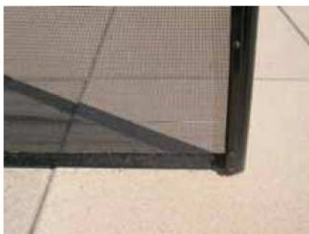
Obrázek 6. Šroub z nerezavějící oceli musí být úplně zasunutý do kotvicího pouzdra (bezpečnostní západka na straně bazénu )
