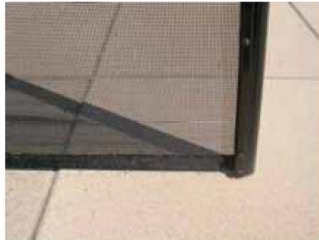
Figuur 6: De roestvrij stalen stangen moeten volledig ingebed zijn in de verankeringsogen (de veiligheidshaak wijst richting zwembad )
