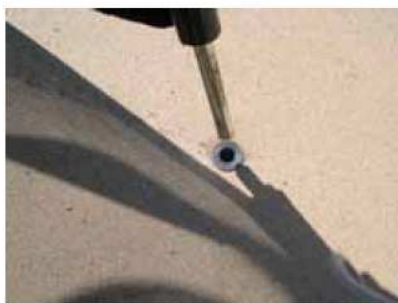
Obrázek 5. Upevnění kotvicího pouzdra do podkladu
