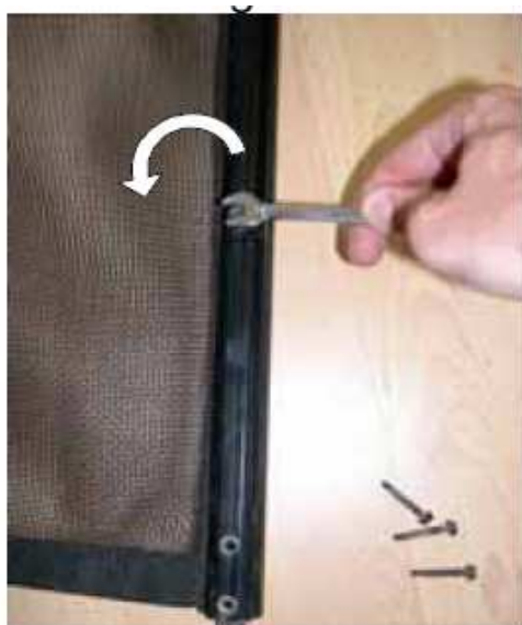
Obrázek 11. Odšroubujte 10 šroubů upevovacích regletů, čímž uvolníte síť
