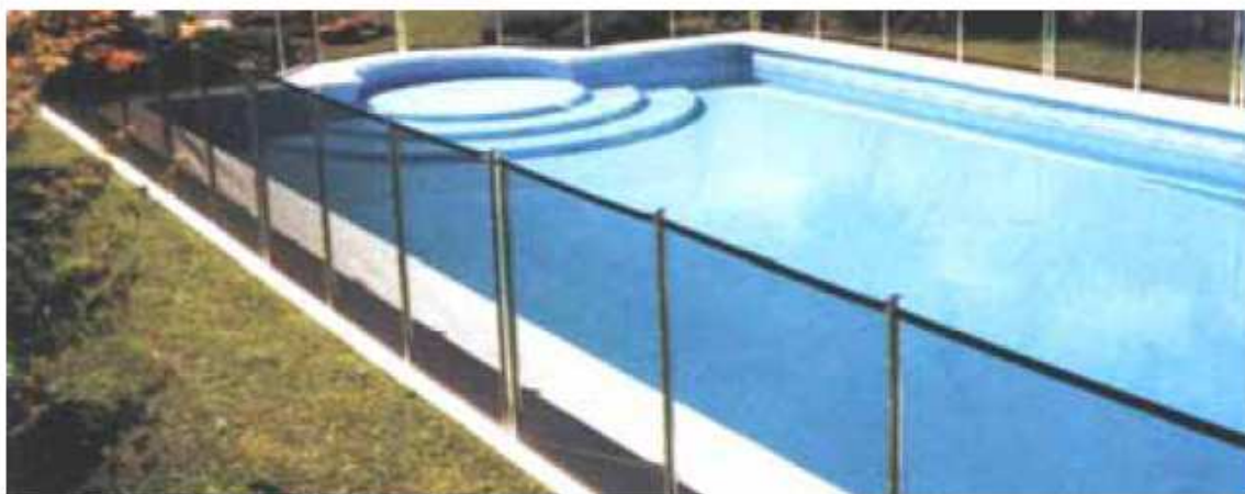
Obrázek 9. Síť mezi jednotlivými sloupky musí být dobře napnutá
