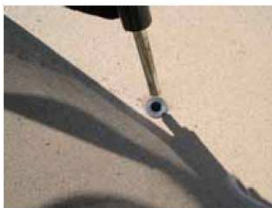
Figura 5. Fixarea tecii de ancorare în sol
