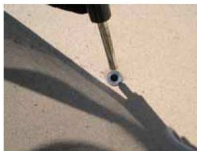
Abb. 5. Befestigung der Bodenverankerungsöse
