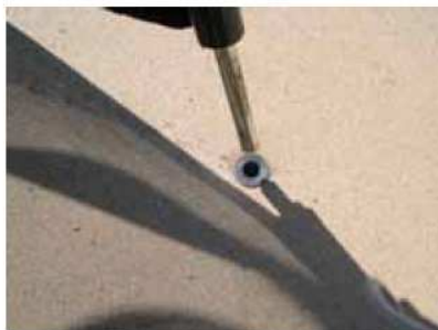
Fig. 5. Fissaggio dell'occhiello di ancoraggio al terreno
