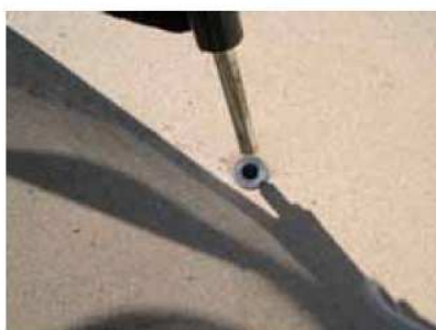
Bild 5. Fästning av golvförankringsbeslag
