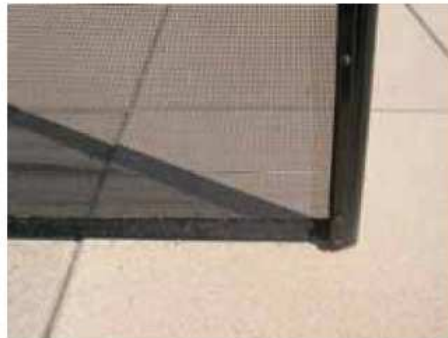
Abb. 6. Die rostfreien Stäbe müssen vollständig in die Verankerungsöse eingelassen sein (Sicherheitshaken zeigt Richtung Schwimmbad )
