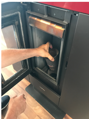
Fig. 68 - Brennschale entnehmen
