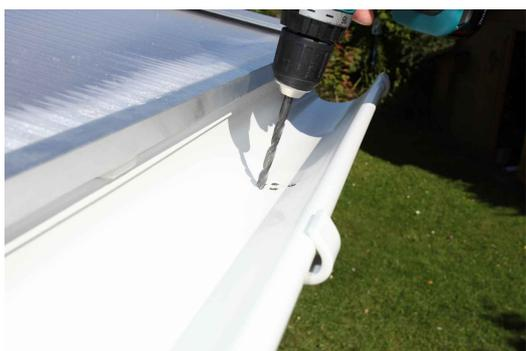
Legen Sie nun die Rinnenteile zum Prüfen der Gesamtlänge lose in die Rinnenhalter. Falls notwendig, ein oder mehrere Rinnenteile mit einer Handsäge auf die gewünschte Länge kürzen. Bohren Sie an dem gewünschten Ende der Halbrundrinne (C160-Längen) ca. 15 Löcher (Ø 9 mm) für den Wasserablauf. Anschließend legen Sie die Halbrundrinnen zusammen mit dem Rinnenablaufstutzen (C164-01/02) in die Rinnenhalter. Nach dem Einhängen müssen ggf. die Radien der Rinnen nachgebogen werden.
