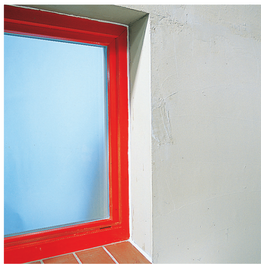
Verschluss der Anschlussfugen zwischen Fenster und Mauerwerk.
