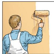
**7.** Après le séchage du papier, la surface doit être repeinte avec une peinture émulsion suivant DIN EN 13300 ou être recouverte de crépi, de papier peint ou similaire.
